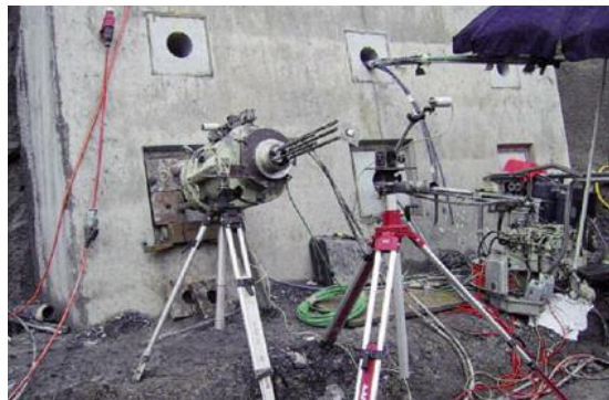
Hangsicherung mit permanenten Anker Länge: 50 – 60 m l; Gebrauchslast: 900 – 1300 kN Thuis – Tiefencastel
