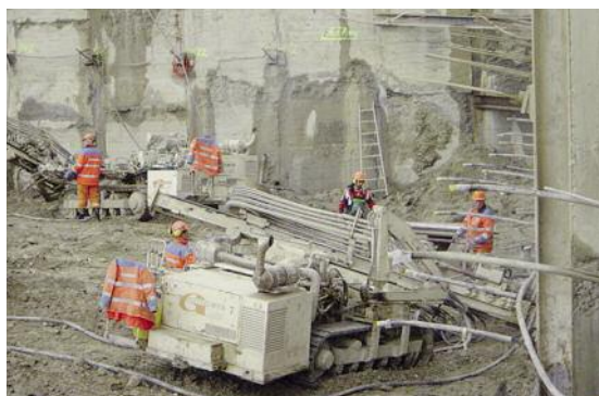
oben: Temporäre Verankerung Spundwand mit Longarinen; Dübendorf
