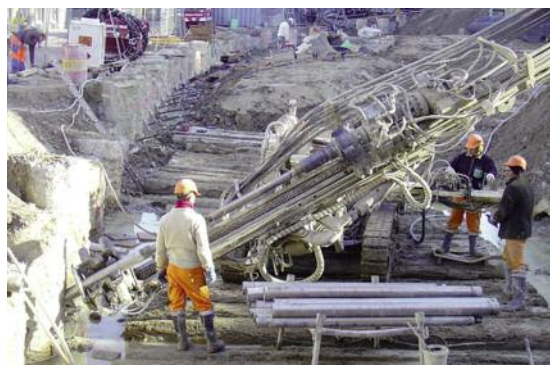
oben: Anker spannen; Baustelle Saas
