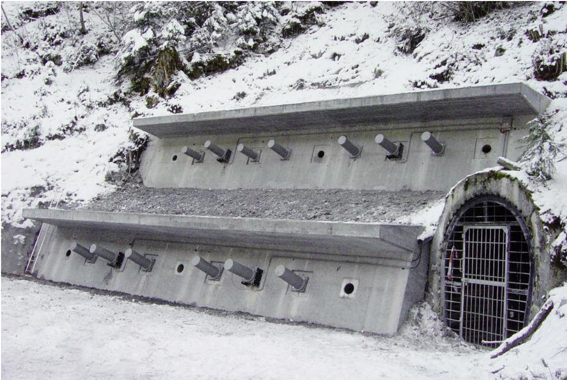
Hangsicherung mit permanenten Anker Länge: 50 – 60 m l; Gebrauchslast: 900 – 1300 kN Thuis – Tiefencastel
