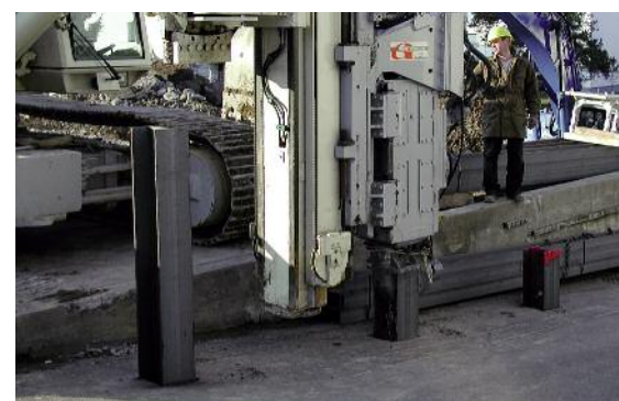
oben: Spritzbeton-Vernagelung in Nesselbach
