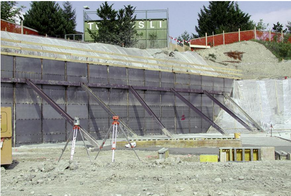
Abgespriesste Rühlwand und Ausfachungen mit Stahlblechen System «Greuter»: Eine wirtschaftliche und zeitsparende Lösung für Ihre Baugruben.
