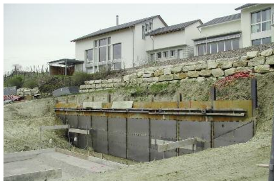
oben: Zürich Dolderpark: Baugrubenabschlüsse mit rückverankerter Rühlwand und Spritzbeton-Vernagelung.
