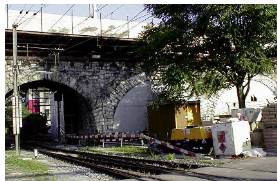
oben: Rohrschirm ABB Power Tower Baden für Gebäudeunterquerung
