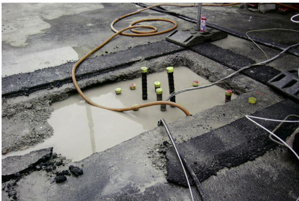
Abdichtungsinjektionen Luzernerring Basel, St. Johann
