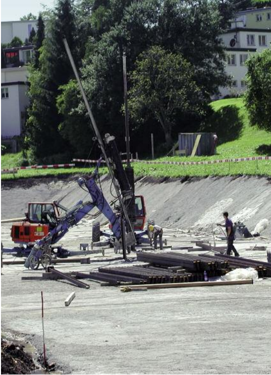
Überbauung Boppartshof, St. Gallen; auch auf reinem Torf und Seekreide sind wir mit unseren leichten Geräten im Element und ermöglichen Bauten, die früher niemand für möglich gehalten hätte.
