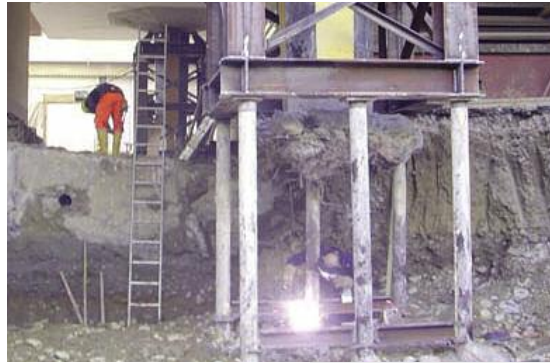
Injektionsbohrpfähle für Umbau Lagerhaus Glesshübelstrasse, Zürich. Den Bauvorhaben sind dank Greuter-Technik heutzutage keine Grenzen mehr gesetzt.
