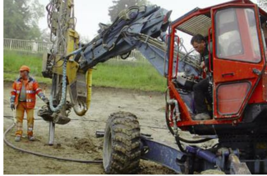
Injektionsbohrpfähle in steilem Gelände in Eglisau, zwischen Hauptstrasse und Rhein; für uns kein Hindernis!
