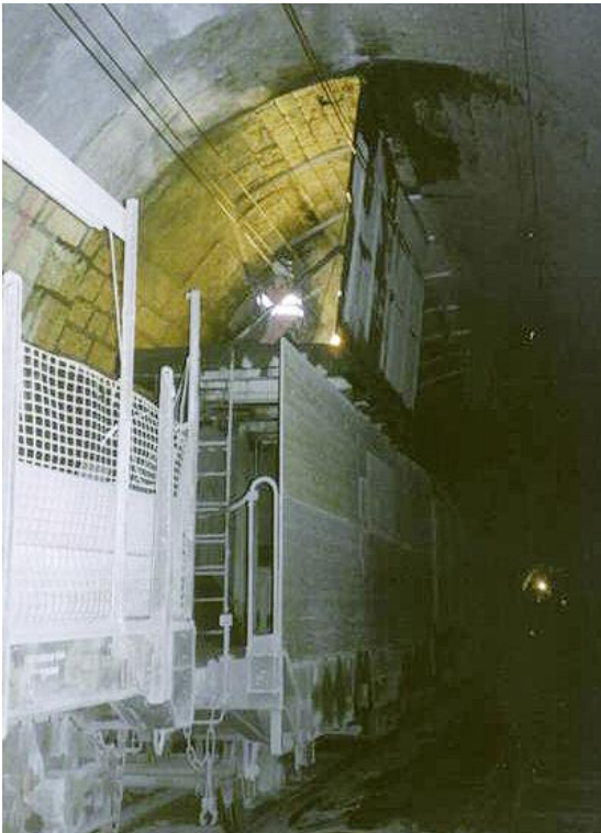
Spezialkonstruktion Hebebühne mit Schutzwand im Doppelspureinsatz.
